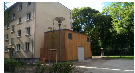
Neu errichtete Energiezentrale © Berliner NetzwerkE, Dietmar Gust
