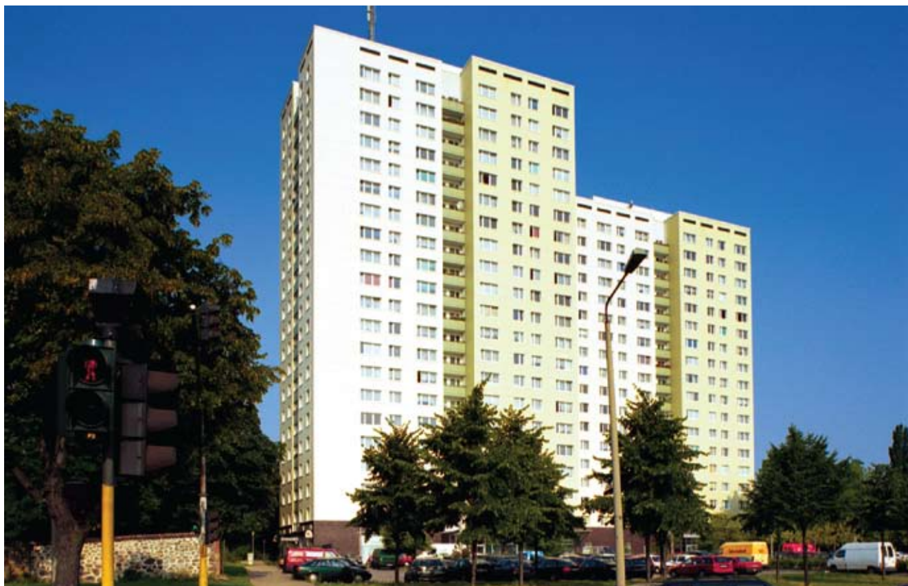
Foto 5: Doppelhochhaus in der Seefelder Str. 48/50
