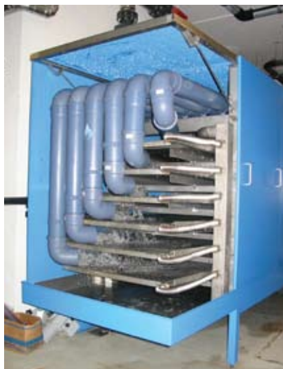
Foto 3: Schmutzwasserwärmeübertrager
